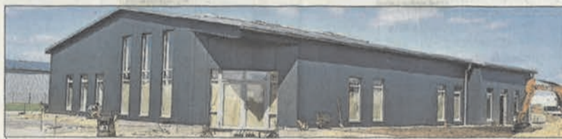
Noch bis kurz vor der Eröffnung wurde an und vor der neuen Halle gewerkelt.
