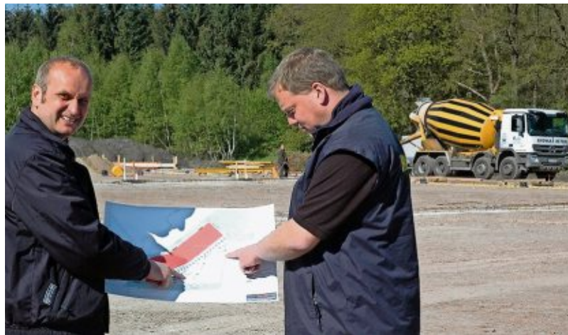
Jan Heldberg (rechts) und Bauleiter Jürgen Rathjen bei der Lagebesprechung auf der Baustelle. Im August soll der erste Teil der Halle stehen.
