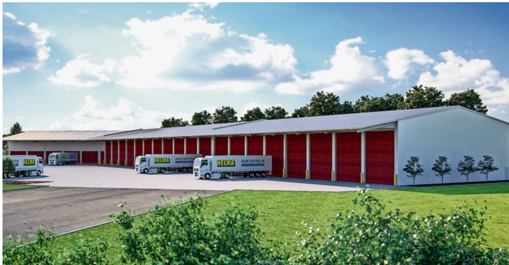
So sieht sie aus, die neue Kühl- und Lagerhalle, die Firma Helma in Sittensen am Ortsausgang Richtung Zeven baut. Das Gebäude soll in zwei Abschnitten hochgezogen werden. Der hintere Teil inklusive Zwiebelhalle soll schon im August fertig sein. Wann die zweite Hälfte in Angriff genommen wird, steht noch nicht fest. Im langen Gebäudeteil werden nur Kartoffeln gelagert. Visualisierung Poort-Bau
