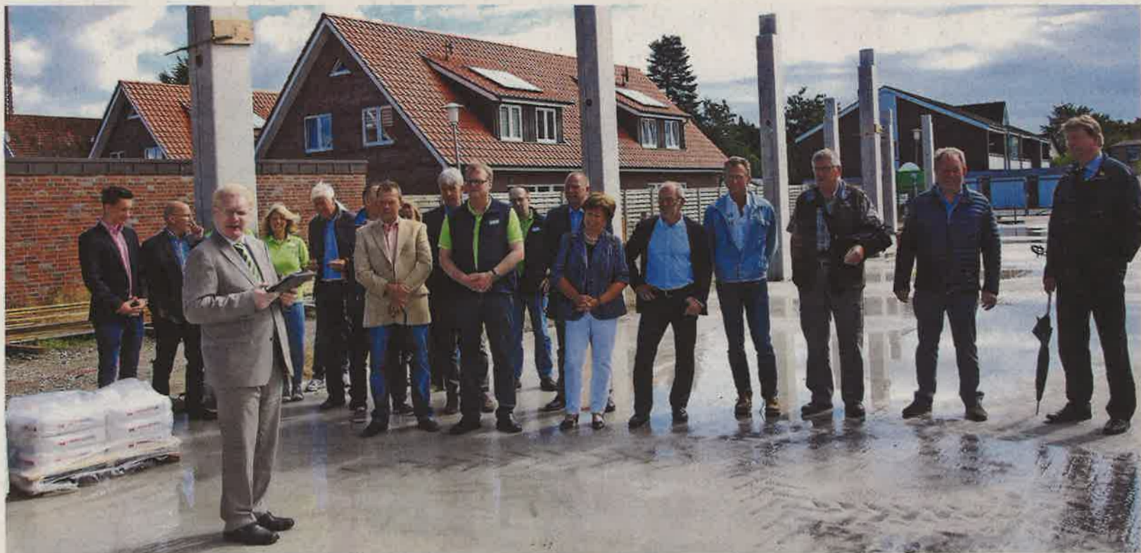
Bei strahlendem Sonnenschein begrüßte gestern Saatzucht-Vorstandsmitglied Axel Lohse die Gäste der Grundsteinlegung.
